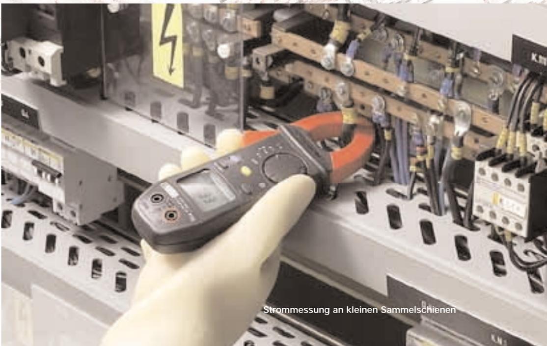
Strommessung an kleinen Sammelschienen
