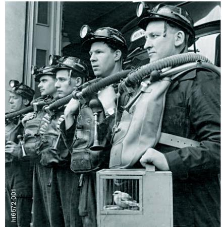
Der historische Ursprung der tragbaren Gasmesstechnik liegt im Bergbau. Bevor Sensoren zum Einsatz kamen, waren Kanarienvögel eine Art Lebensversicherung. Die extrem empfindlichen Finken reagieren bei Sauerstoffmangel.
