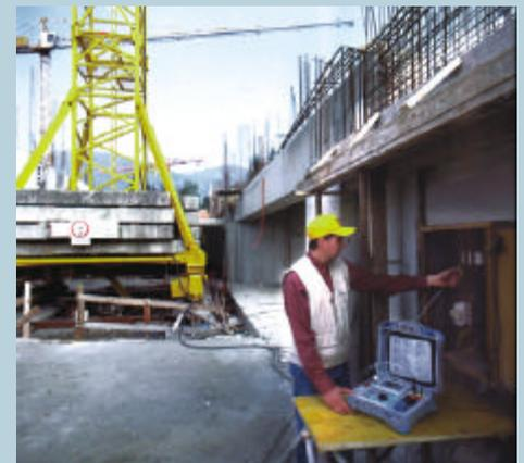
Elektrische Sicherheitsprüfung an einem Schaltverteiler
