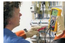
Isolationsprüfung an einer Unterverteilung
