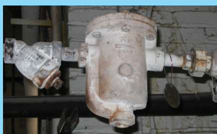
Wenn ein Kondensatabscheider wie in diesem Beispiel einwandfrei funktioniert, zeigt das Wärmebild einen hohen Temperaturunterschied.
