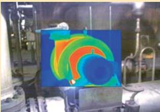
**Bild-im-Bild:** Liefert einen Bezugsrahmen, indem nur ein bestimmter Ausschnitt des Sichtbilds durch ein Wärmebild-ausschnitt ersetzt wird.
