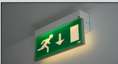
Messen der Notbeleuchtung von Fluchtwegen
