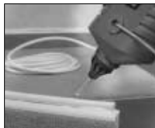
Förläggning av telefonkabel.
