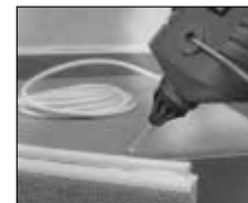
Telefona kabeļu izvietojšanai.
