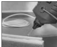
Pokladanie telefónnych káblov.
