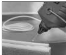
Telefonkábel fektetése.
