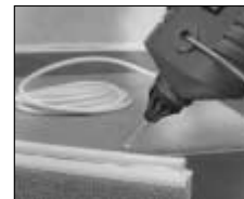
Polaganje telefonskih kablov.
