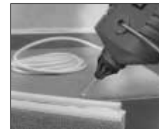
Posa di cavi del telefono.
