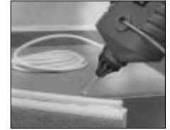
Telefon kablosu döşeme.
