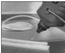
Прокладка телефонного кабеля
