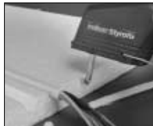
U-veida profilgropju izgriešana kabelju izvietošanai izolācijas plātnēs.
