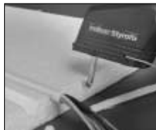
U-profiiliga lõigete tege- mine kaabli paigaldamisel isolatsiooniplatidesse
