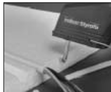
Profilové U řezy k uložení kabelů v izolačních deskách
