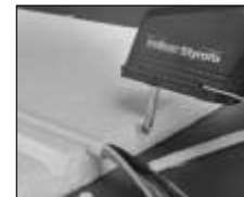
Decupări în profil U pentru paturi de cablu în plăci de izolare
