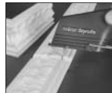
Аккуратного отрезания гипсовых планок
