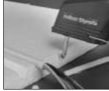
Yalıtım plakaları içine kablo döşeme uygulamasında U profil kesimi
