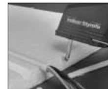
Cortes de perfiles en U para canalizaciones de cables en placas de aislamiento
