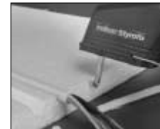
Τομές προφίλ U στην εγκατάσταση καλωδίων σε μονωτικές πλάκες
