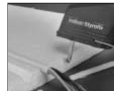
U-profielsneden voor het leggen van kabels in isolatieplaten
