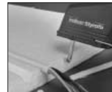
U-profilspår vid kabelläggning i dämpplattor
