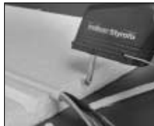
U-tverrsnitt til nedlegging av kabler i isolasjonsplater
