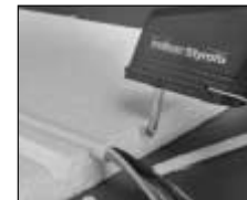
Rezanje U-profila za umetanje kabela u izolacijske ploče
