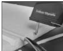
Découpage de profilés en U pour le passage de câbles dans les panneaux isolants
