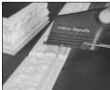
Saubere Abschnitte bei Stuckleisten
