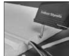
Вырезания U-образных профилей для помещения кабеля в изоляционные плиты
