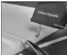
Cortes de perfil em U para a colocação de cabos em placas de isolamento
