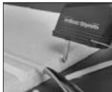
U-profilsnit i forhold til kabelintegration i isoleringsplader
