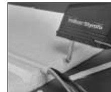
Eristyslevyjen U-profiilileikkaukset johtoja varten
