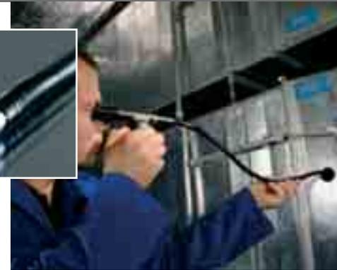
Prüfung im Klimakanal mit Schwanenhalsummantelung, mittlere Flexibilität
