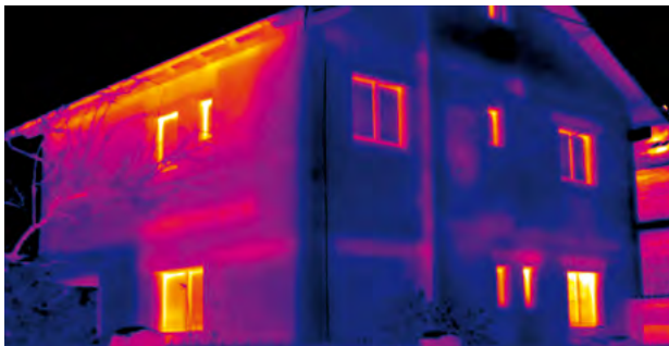
Bauhandwerk: Wärmeverluste von Gebäuden aufspüren.
