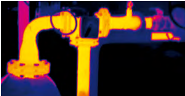
Heizungshandwerk: Zeit und Ressourcen sparen.
