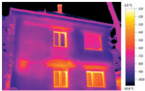
Wärmebild mit testo ScaleAssist
