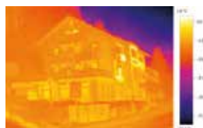
Wärmebild ohne testo ScaleAssist
