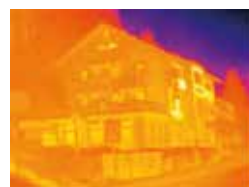
Wärmebild ohne testo ScaleAssist
