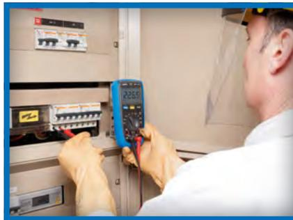
**Wartungsarbeiten an elektrischen Anlagen** in Büro- oder Gewerbegebäuden werden durch die Spannungsmessung mit niedriger Impedanz  $V_{\text{LowZ}}$  besonders vereinfacht, da sie Phantomspannungen, wie sie in Computernetzwerken oft vorkommen, zuverlässig unterdrückt.
