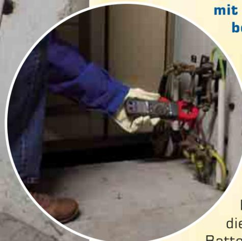
Zangenöffnung maximal 28 mm mit einer weitgehenden Störunempfindlichkeit.
