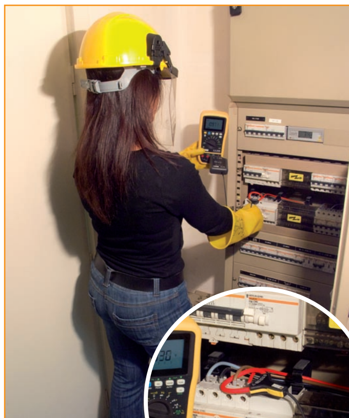
Die Flexibilität der Stromwandler ist besonders bei Messungen an Schalttafeln im Industrie- und Wohnbereich hilfreich.
