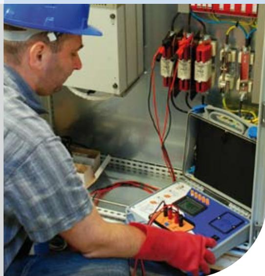
Der Hochstrom-Impedanztester Euro Z 290 A ist ein tragbares Prüfgerät für den professionellen Einsatz zur **Messung niedriger Impedanzen** in Umgebungen bis zu **310 V CAT IV**. Er kann eigenständig oder in Kombination mit den METREL-Messinstrumenten betrieben werden. **Hochpräzise Leitungsimpedanz-** und **hochpräzise Fehlerschleifenimpedanz-**Messungen im Bereich von  $1 \text{ m}\Omega$  bis zu  $19,99 \Omega$  sind seine hervorstechenden Leistungen.
