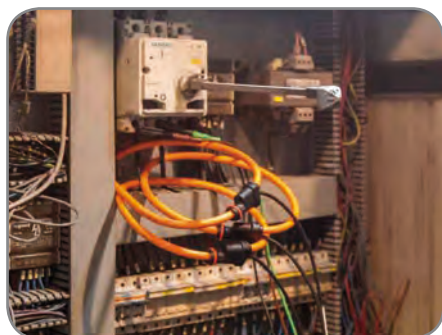
Messung Einsatz der flexiblen Stromwandler
