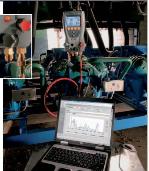
Service und Wartung beim testo 556 und 560 inkl. Inbetriebnahme einer Kälteanlage
